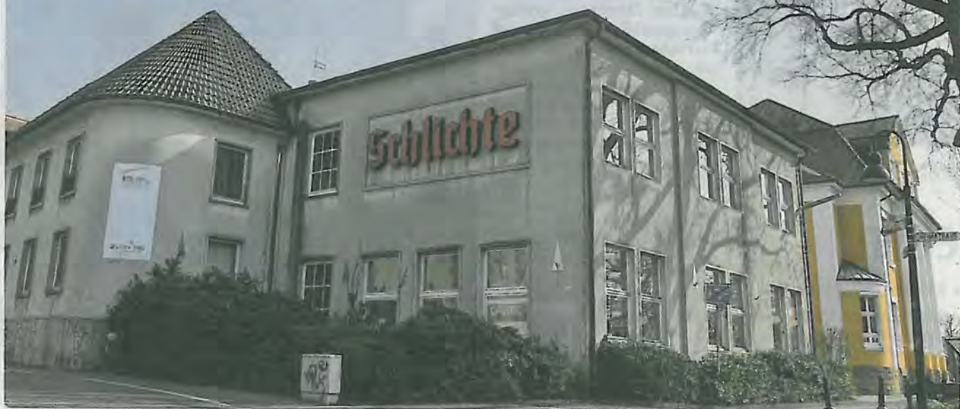
Die Tage scheinen gezählt: Der der Kirche zugewandte Teil des Schlichte-Carrees soll abgerissen werden.
